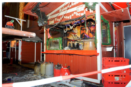
Abb. 10: Weihnachtsmarktstand nach Verpuffung bei Gasflaschenwechsel
